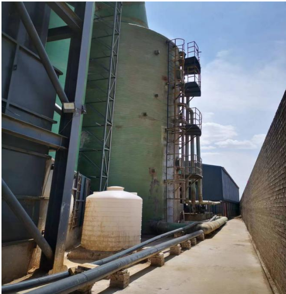
图 3-3 脱硝设施
